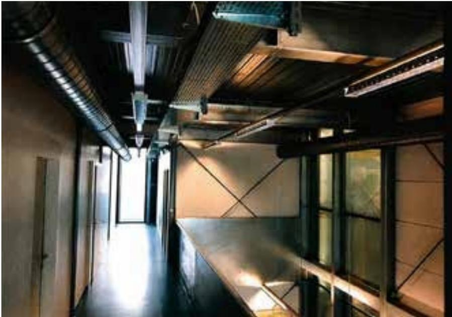
Durch die kleineren Emissionsgrade verzinkter Profile kann eine R30-Brandschutzanforderung mit Feuerverzinkung ohne zusätzliche Massnahmen erreicht werden.
